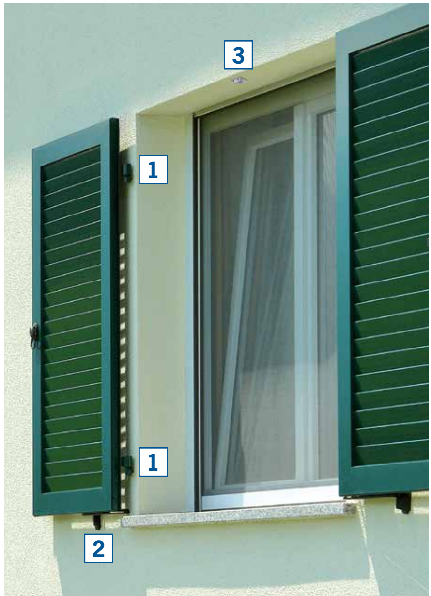
2 Befestigung des Rückhalters in der Fassade mit Montagezylinder ZyRillo-eps Ø 70
