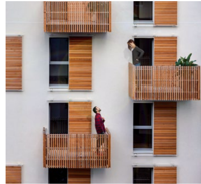
Fensterläden. Faltscherenläden, Faltschiebeläden, Schiebeläden, Klappläden.
